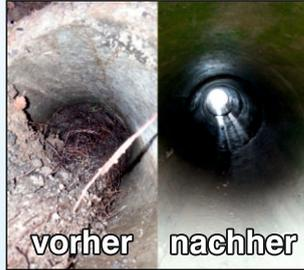
**Kraftvoller Fräser** zum Schneiden, Fräsen und Schleifen in Rohren mit einem Durchmesser von DN 75-200 mm. Das gilt unabhängig vom Material und unabhängig davon, ob das Rohr gerade verläuft oder Biegungen aufweist. **DC SUPER FLEX** ist ein flexibler und ultramoderner Fräser, bei dessen Entwicklung und Verfeinerung **DANCUTTER** den Fokus auf **Zuverlässigkeit, Einfachheit und Zeitersparnis für die Kunden** gerichtet hat.
